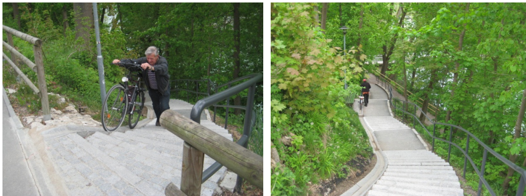
Abb. 22: Die steile Verbindung vom bestehenden Lechsteg zu v. Kühlmannstraße
