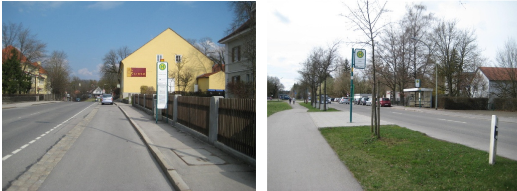
Abb. 30: Bestehende Bushaltestelle ohne Wetterschutz, ohne Sitzgelegenheit und Linienplan an einem viel zu schmalen Gehsteig verringert die Attraktivität des ÖPNV (linkes Bild). Rechts Beispiele für zielkonforme Haltestellen.
