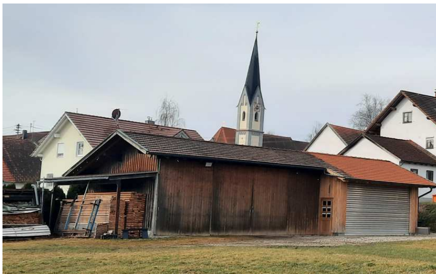
Abb. 12: Blick auf Stadel mit Garage (Baufeld 08) (AGL, März 2025)
