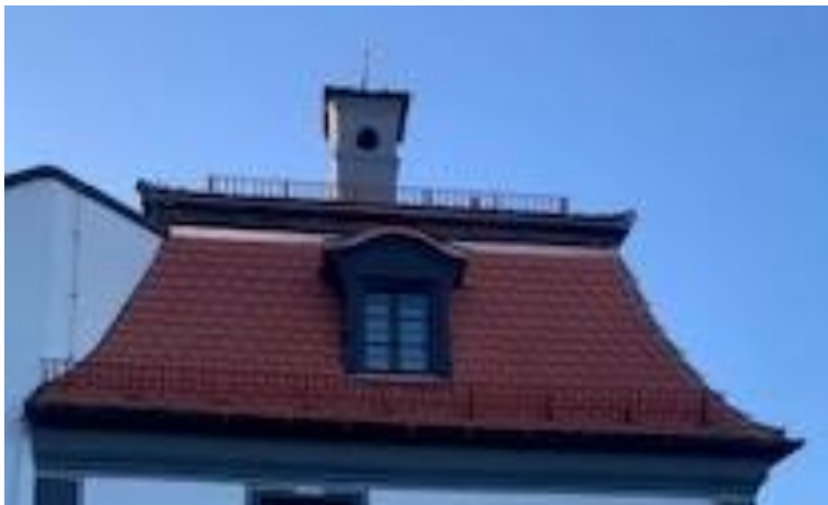
Dach des Turmes nachher
