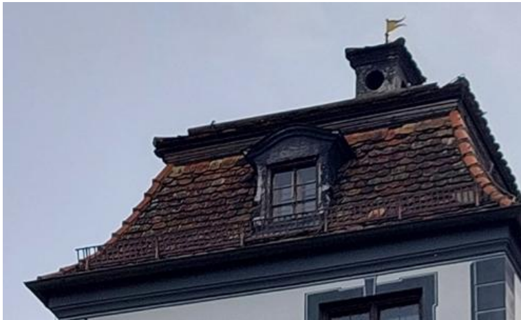
Dach des Turmes vorher
