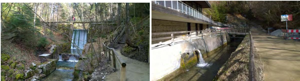
Abbildung 8.29: Links: Stauwehr am Stauweiher. Rechts: Kastenprofil aus Beton im Mündungsbereich.
