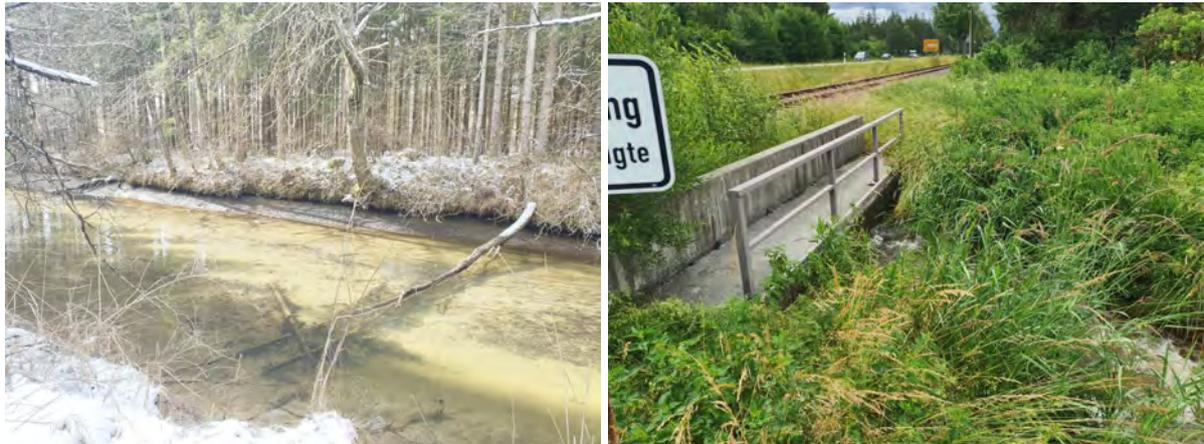
Abbildung 7.37: Links: Verschlammter, strukturarmer Mündungsbereich in den Lech. Rechts: Kritische Engstelle im Bereich der Unterführung unter B17 oberhalb des Gewerbegebietes Lechrain.
