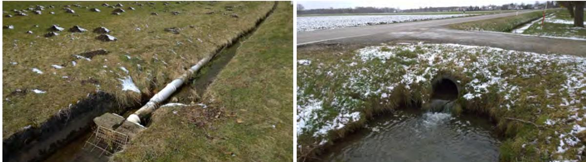
Abbildung 7.7: Links: Querbauwerk mit Ausleitung für Fischteich bei km 3,7. Rechts: Rohrdurchlass mit Absturz bei km 1,74.
