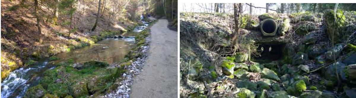
Abbildung 8.28: Links: Dorfängerbach mit Sohl- und Uferbefestigung, Bereich zwischen Stauweiher und Mündung. Rechts: Straßendurchlass Dorfängerbach bei km 0,8.
