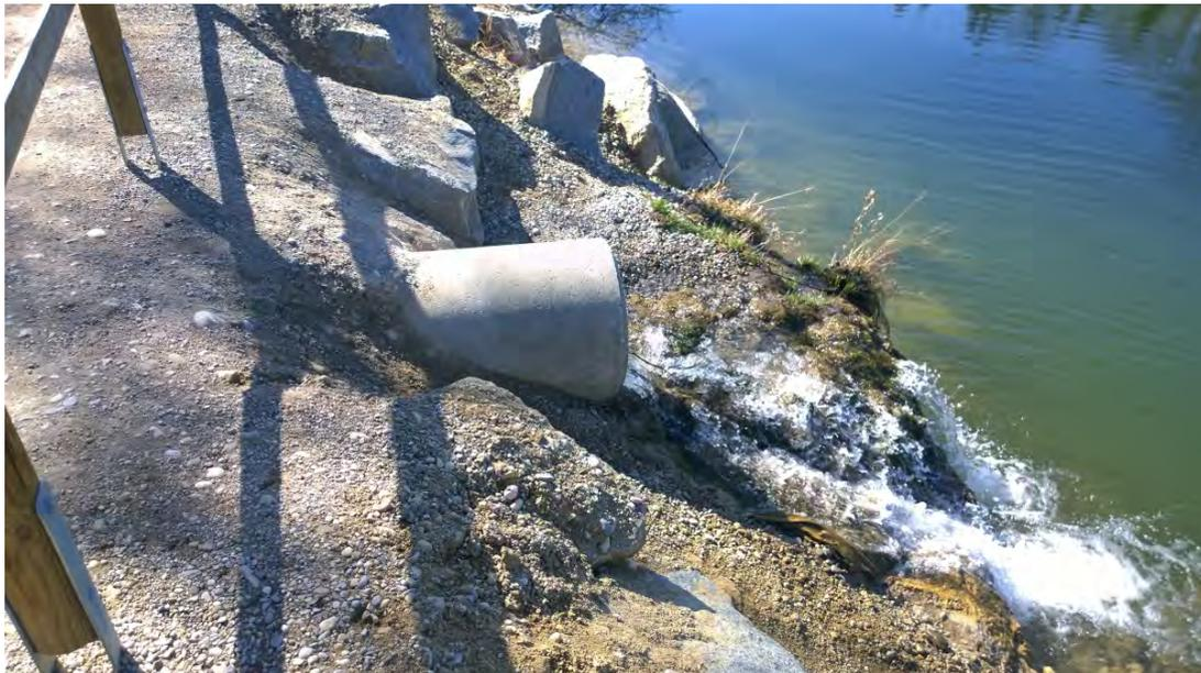
Abbildung 8.16: Rohrdurchlass mit Absturz an der Mündung von Gewässer 12599314.
