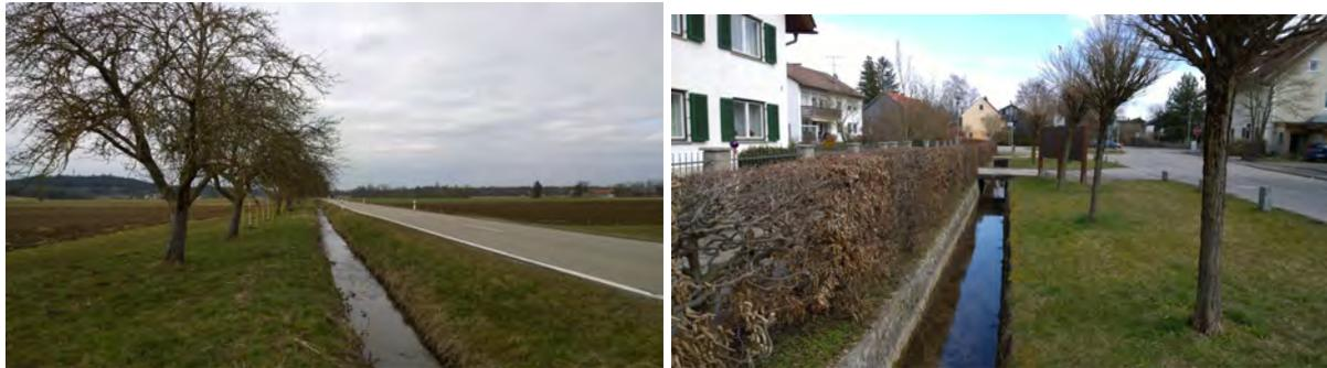
Abbildung 7.6: Links: Begradigter Verlauf des Luibaches zwischen Erpfting und der A 96. Rechts: In der Ortschaft Erpfting liegt der Bach begradigt in einem Kastenprofil.
