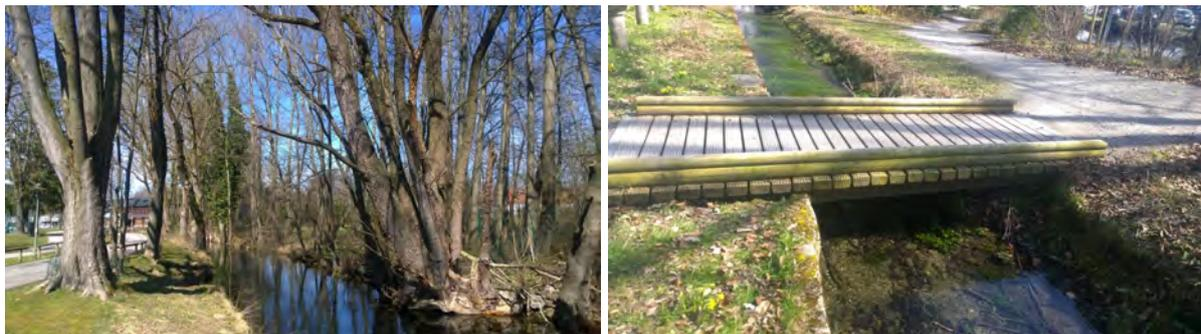
Abbildung 7.27: Links: Vergleichsweise naturnaher Gewässerabschnitt im Mittellauf. Rechts: Ausgebautes Querprofil mit durchgehendem Steinsatz im Uferbereich.
