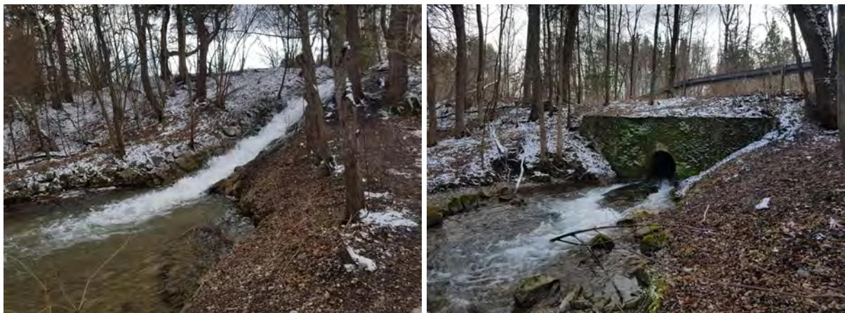
Abbildung 7.38: Links: Nicht durchgängige raue Rampe im Unterlauf des Wiesbaches. Rechts: Rohrdurchlass oberhalb der Mündung in den Lech.
