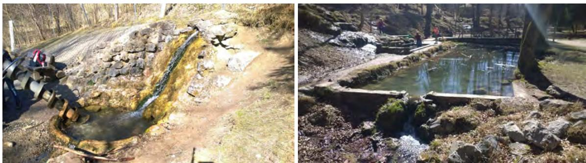
Abbildung 8.15: Links: Absturz aus Verrohrung am Wasserspielplatz am nördlichen Zufluss von Gewässer 12599314, bei km 0,72. Rechts: Staubecken mit Überlauf am nördlichen Gewässerarm von Gewässer 12599314 bei km 0,55. Links davon ein Wassertretbecken.
