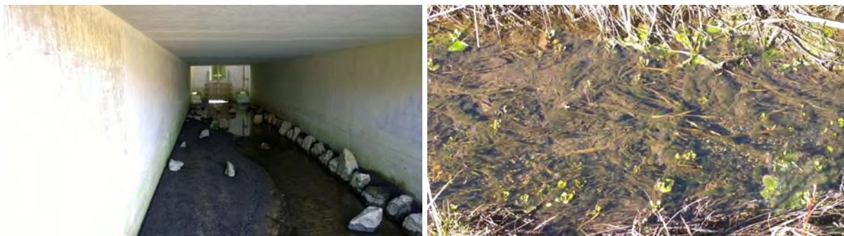
Abbildung 7.14: Links: Brückendurchlass mit Sedimentauflage. Rechts: Erhebliche Algenbildung auf der Gewässersohle.
