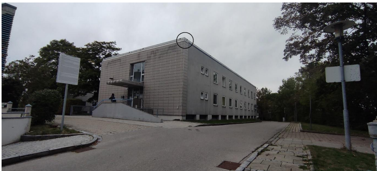
Abbildung 13: Ansicht der Südostseite des Gebäudes Bürgermeister-Dr.-Hartmann-Straße 58 mit Quartier des Großen Abendseglers (Kreis)
