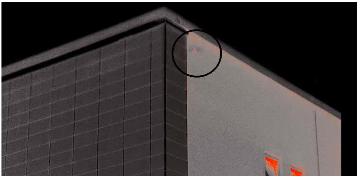
Abbildung 14: Ausflug des Großen Abendseglers an der Südfassade des östlichsten Wohnblock-Gebäudes
