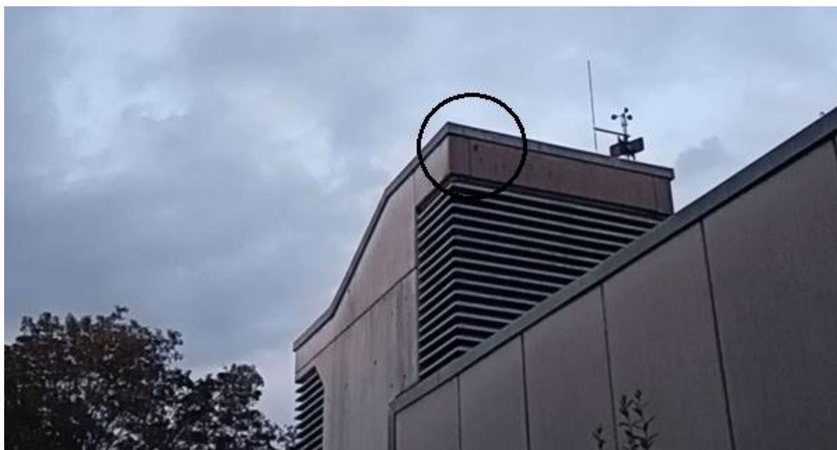
Abbildung 16: Zwergfledermaus während des Ausflugs aus dem Spalt zwischen Fassade und Dach
