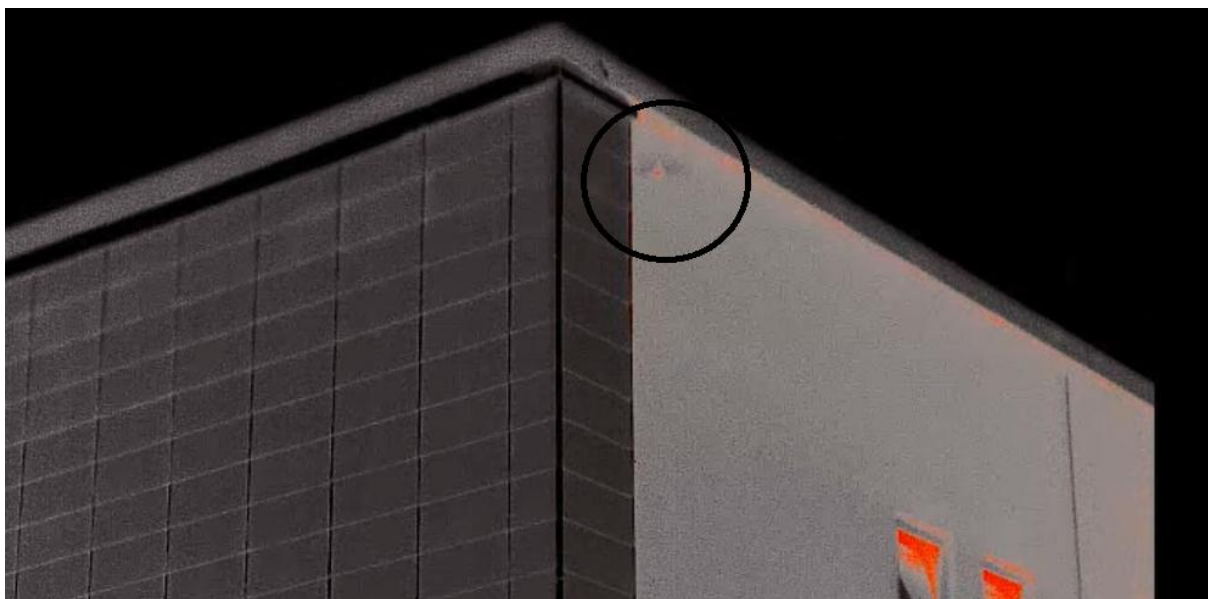
Abbildung 15: Ausflug des Großen Abendseglers an der Südfassade des östlichsten Wohnblock-Gebäudes
