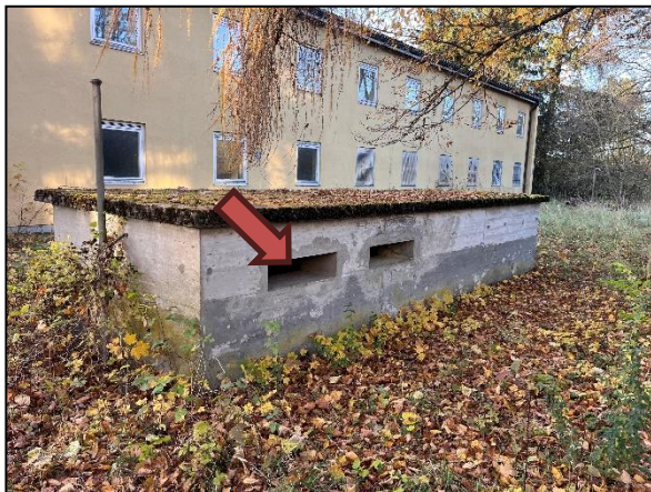
Bild 07: Im Nordwesten des UG befindlicher tiefer Schacht mit freiem Einflug
