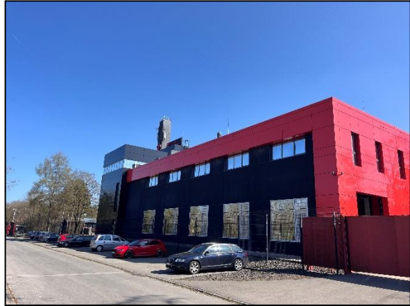
Bild 12: Typisches Beispiel eines Neubaus mit eher geringem Quartierpotenzial
