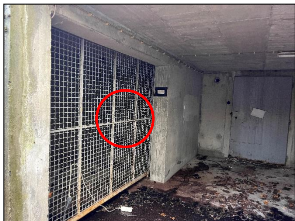
Bild 10: Die eigentlichen Kellerräume konnten nicht begangen werden (Gefahr wegen Gasen), sind aber über Spalten und Lüftungszugänge zugänglich für Fledermäuse
