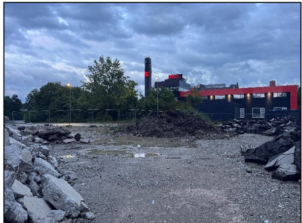
Bild 22: Kurzfristige Bildung von Pfützen nach Regen im zentralen Bereich
