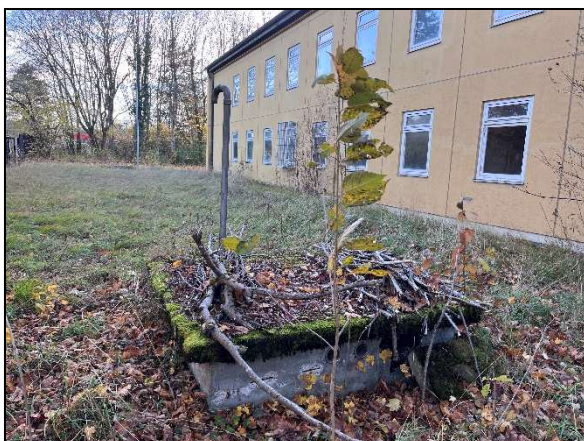
Bild 11: Diverse Lüftungsschächte deuten aber auf ausgedehnte Kellerbereiche hin
