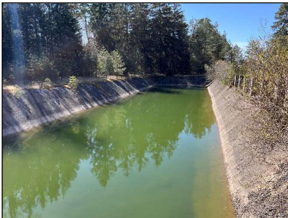
Bild links: Gewässer G2 - Blick vom Nordrand nach Süden
