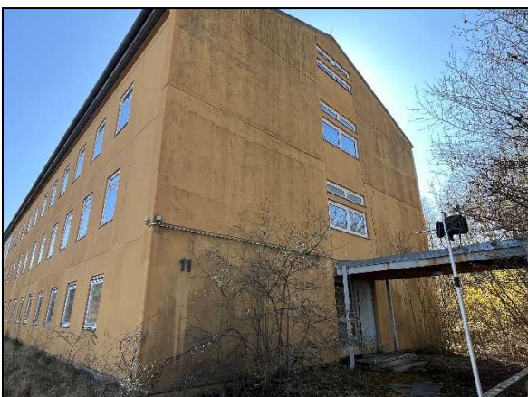
Bild 05: Typisches Gebäude aus dem Altbestand mit unterschiedlich hohem Quartierpotenzial
