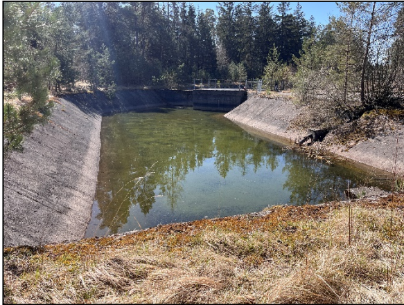
Bild links: Gewässer G1 - Blick vom Nordrand nach Süden
