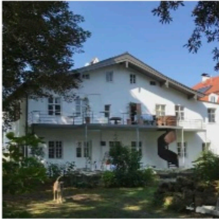
Sanierung und Umbau Baudenkmal Seerichterhaus, Dießen am Ammersee Denkmalschutzmedaille 2024 Fassade zum Garten mit neuer, filigraner Balkon- und Terrassenkonstruktion Auftraggeber: privat
