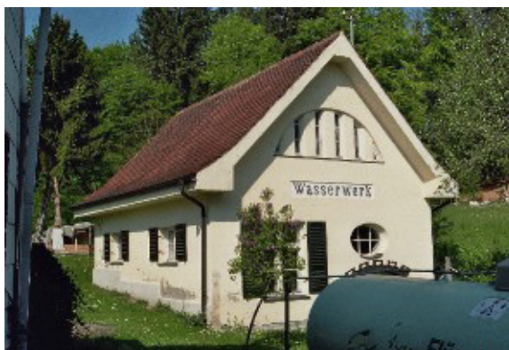
Wasserwerk (südlicher Ortseingang)
